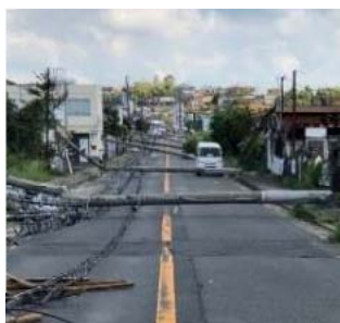
<電柱の倒壊による道路閉塞の事例>
