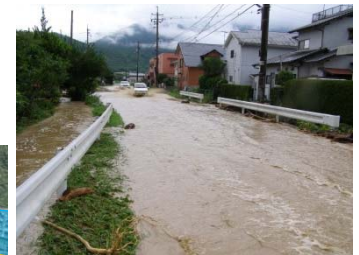
<H21.7月洪水浸水状況>
