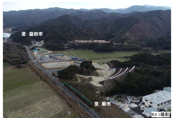
【写真①】木与地区の施工状況
