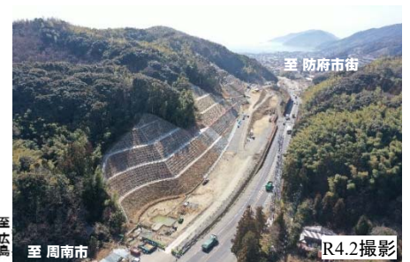
【写真①】樺峠地区の施工状況
