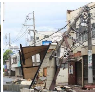
<飛来物による電柱倒壊の事例>
