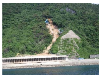
【写真③】H23年土砂崩壊の状況
