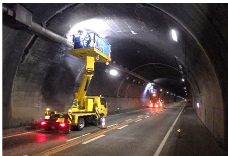
トンネル点検車における点検状況（イメージ）
