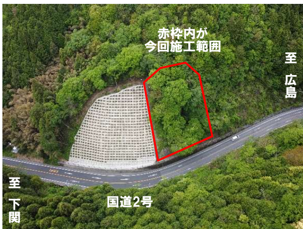
補強工事前写真（R4.5）
