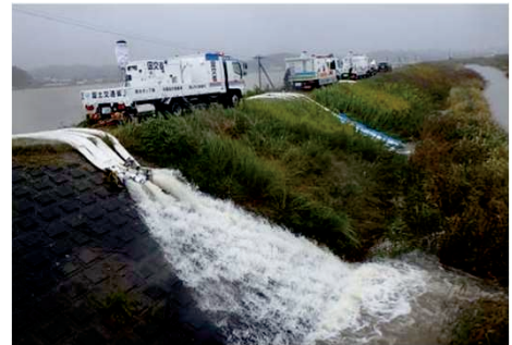
令和元年台風19号 排水ポンプ車活動
