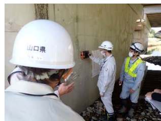
非破壊検査機器：RCレーダーによる鉄筋探査
