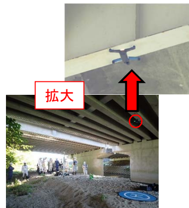
点検支援技術：ドローンによる近接目視
