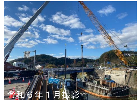
写真（工事状況）
