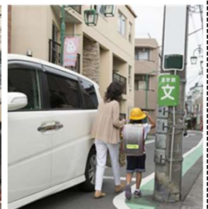
<歩行者の支障となる電柱の事例>
