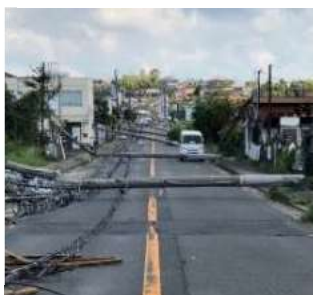
<電柱の倒壊による道路閉塞の事例>
