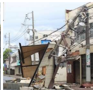
<飛来物による電柱倒壊の事例>
