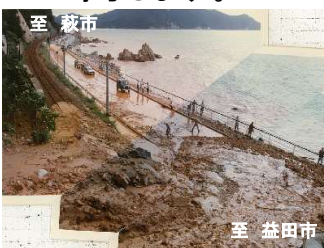
【写真②】S55年土砂崩壊の状況
