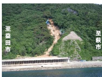
【写真③】H23年土砂崩壊の状況
