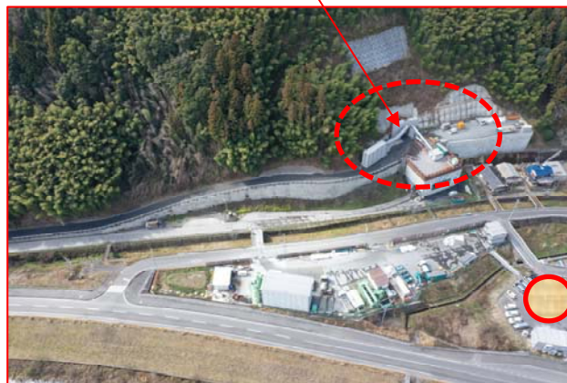
いわくに ②岩国トンネル工事現場
