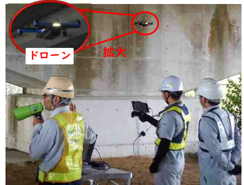
点検支援技術（ドローン）による 点検の実演と解説の様子【令和6年10月開催】
