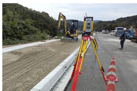
ICT技術を用いた歩道の施工
