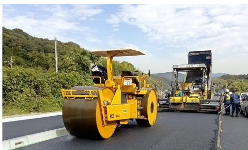
アスファルト舗装の施工
