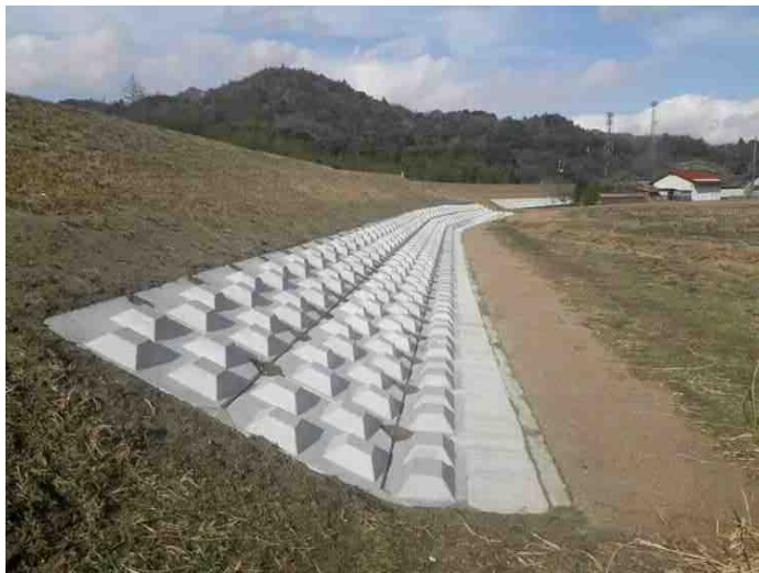
堤防裏法尻補強の施工完了箇所 (山口市徳地伊賀地)
