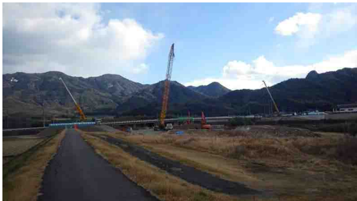
流下能力対策の一環として進めている睦美橋の架替えと築堤 (H30年1月中旬撮影、防府市鈴屋地先)
