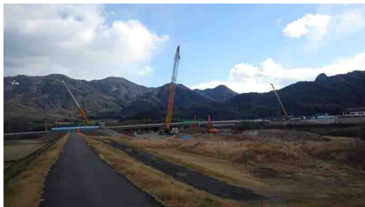
流下能力対策の一環として進めている睦美橋の架替えと築堤 (H30年1月中旬撮影、防府市鈴屋地先)
