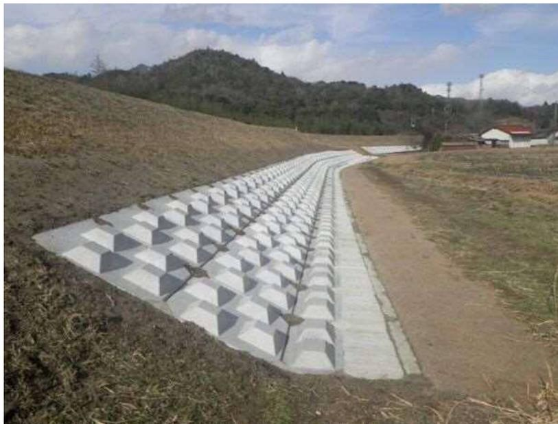
堤防裏法尻補強の施工完了箇所
