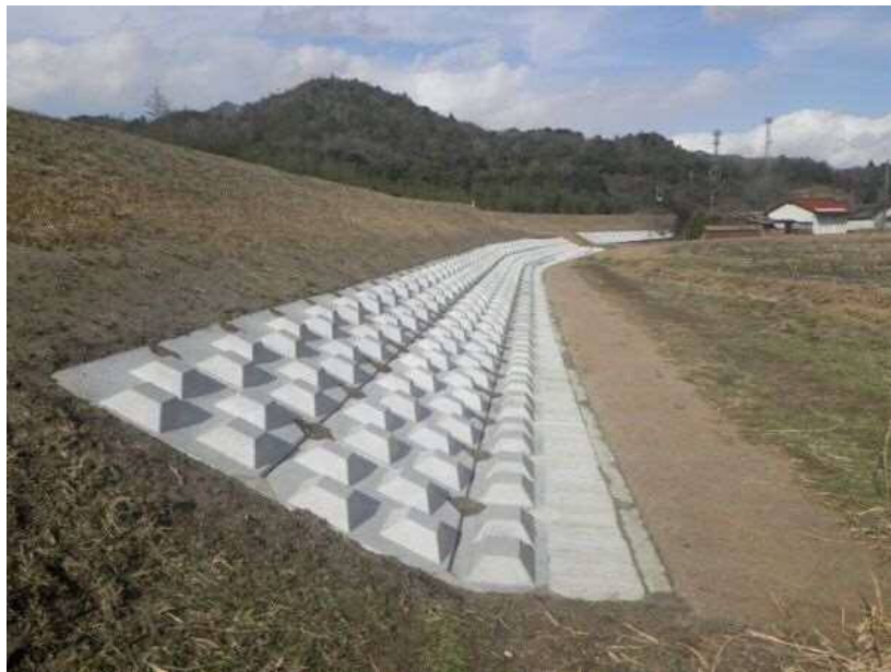
堤防裏法尻補強の施工完了箇所 の状況（山口市徳地伊賀地）
