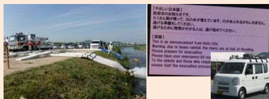
TEC-FORCEによる緊急排水活動訓練
