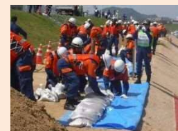
改良積土のう工法
