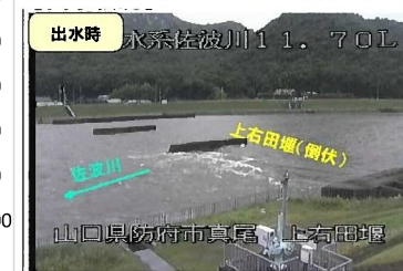
上右田堰の出水状況
