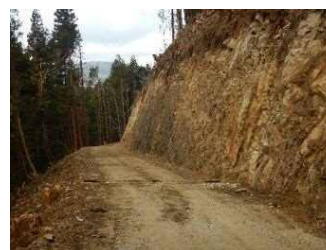
【森林整備：林道(整備)】
