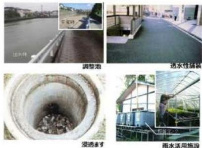
雨水貯留浸透施設の例
