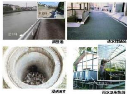
雨水貯留浸透施設の例
