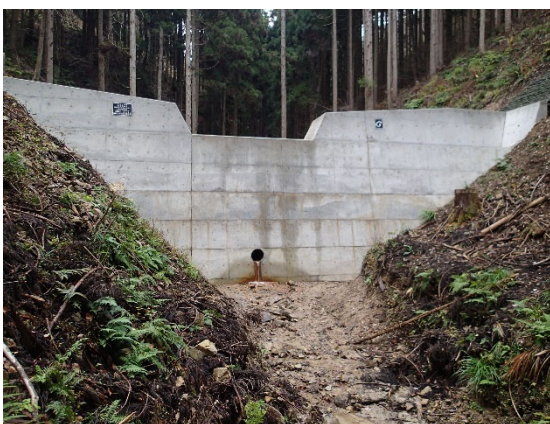
治山ダム 完成状況
