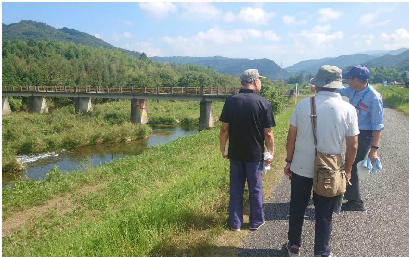
住民との共同点検の様子(R7年8月31日)
