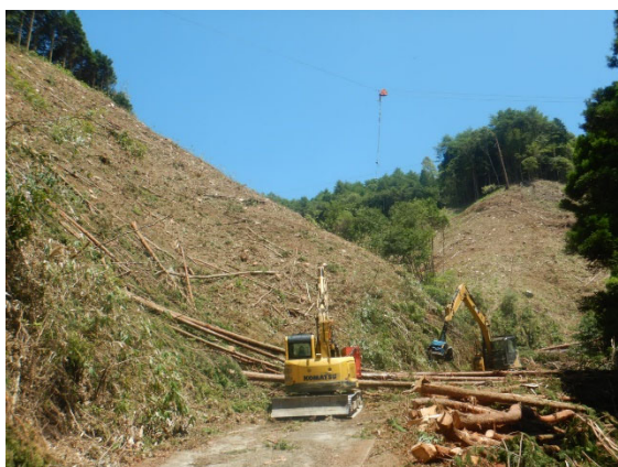
保護伐作業 搬出状況
