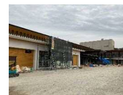
施工状況（外観）
