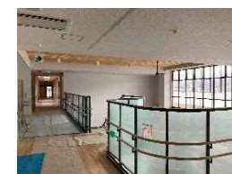
施工状況（内装）
