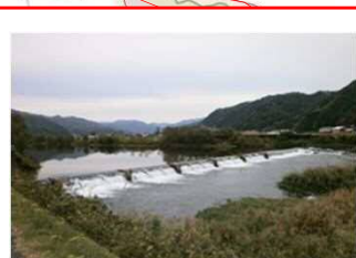
固定堰の改築(岸見堰など)
