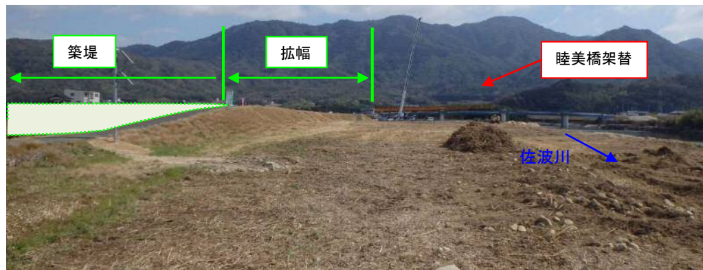
佐波川右岸(12.2k～12.6k)の堤防の延伸と拡幅(防府市奈美地区)
