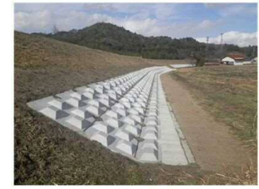
堤防裏法尻補強の施工完了箇所（山口県徳地伊賀地）
