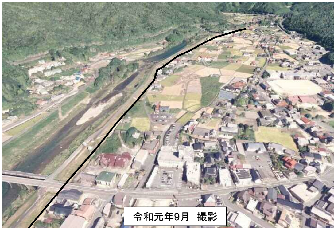
25k800付近 完成状況
