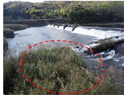
魚道直下流に土砂が堆積している
