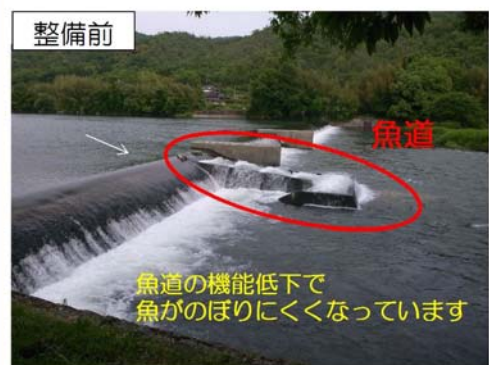
水の流れが集中し、流速が速い魚道の例（鈴屋堰）
