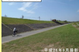
堤防法面の状況
