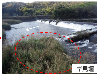
魚道直下流に土砂が堆積している
