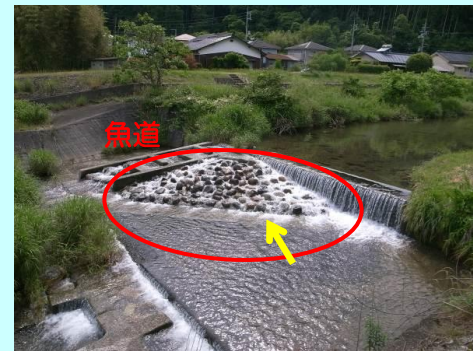
【整備後の魚道の例】
