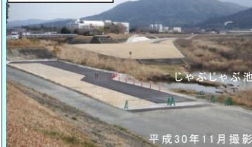
高水敷の整備
