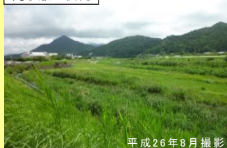
高水敷の状況
