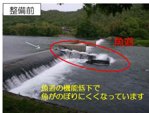
水の流れが集中し、流速が速い魚道の例（鈴屋
