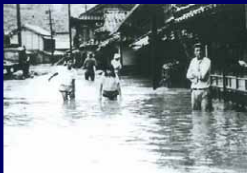
徳地町堀・堀小学校付近浸水状況
