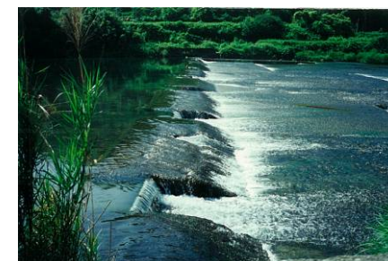
固定堰の一例 (19.8付近・麻生堰)
