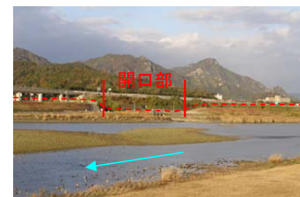
開口部の一例 (2.8k右岸・甲久保川合流点)
