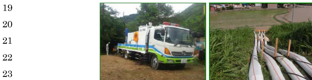
排水ポンプ車の活動状況
