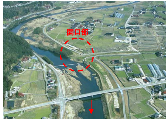
開口部の例（古森川合流部）
