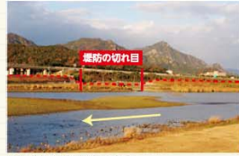
堤防の切れ目の一例(甲久保川)
