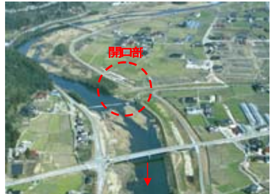
開口部の例（古森川合流部）
