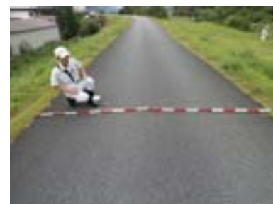
堤防の点検状況
