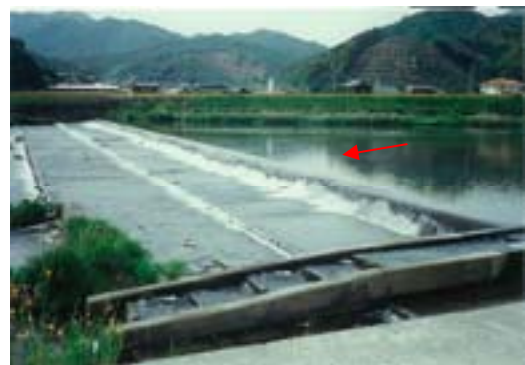
固定堰の例（西大津堰）
