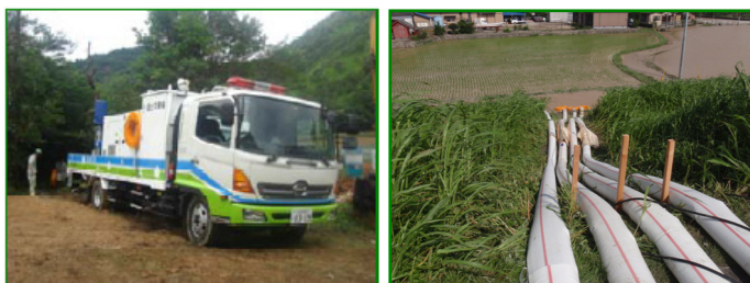
排水ポンプ車の活動状況
