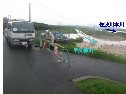
甲久保川合流点における浸水状況
