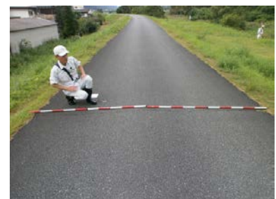
堤防の点検状況
