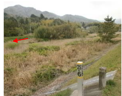
樹木繁茂の状況
