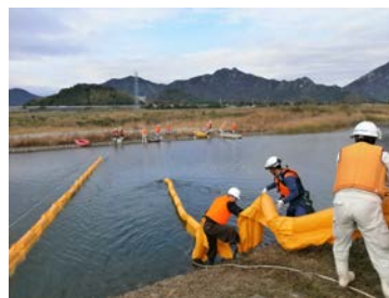
水質事故対応状況
