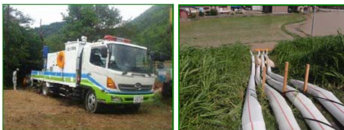
排水ポンプ車の活動状況
