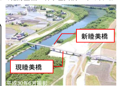
河川改修: 奈美地区 (堤防整備に伴う睦美橋の架け替え)
