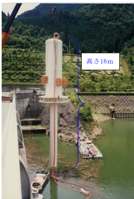
深層曝気施設
