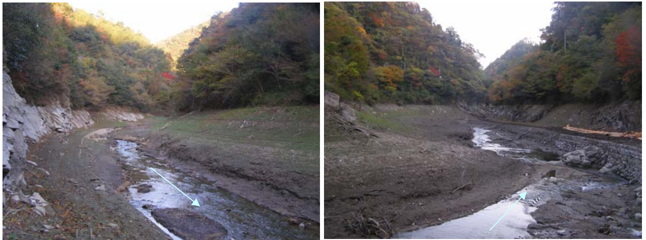
図 4-12 M-22 右岸付近の状況(平成 22 年 11 月 15 日)
