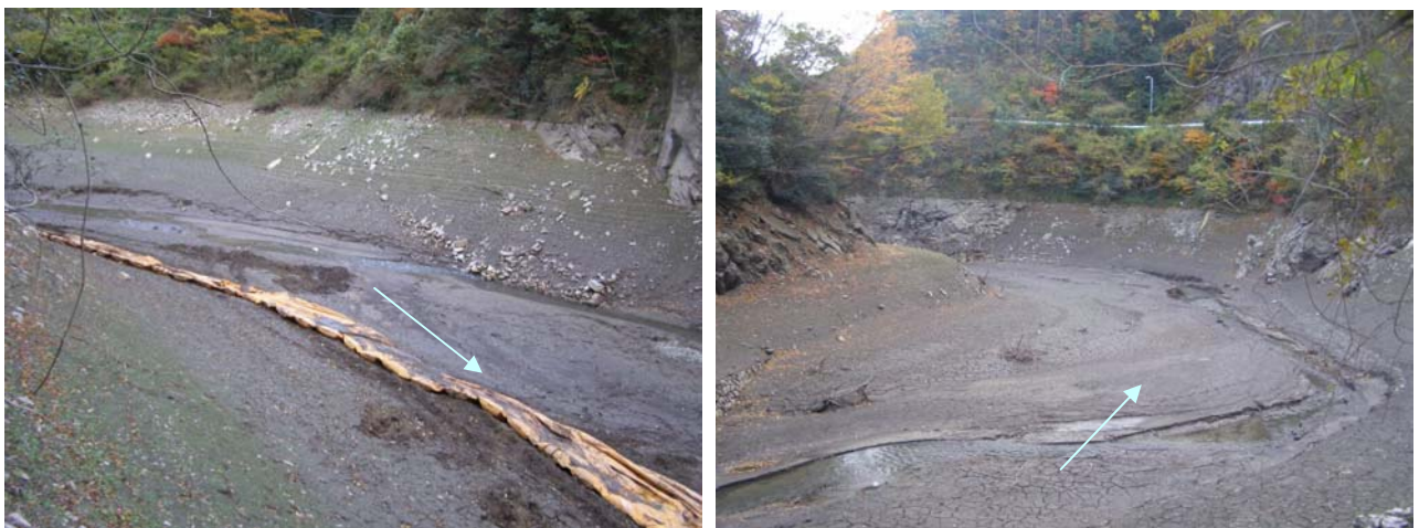
図 4-14 M-19 右岸付近の状況(平成 22 年 11 月 15 日)
