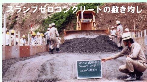
コンクリートの上を重機が走っている
