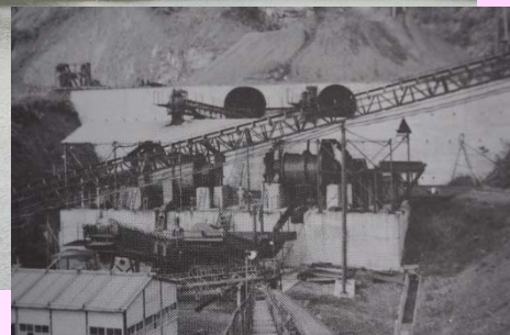
【写真上】長瀬地区の骨材プラント跡地 【写真右下】建設中の骨材プラント
