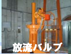
ダム堤体内部
