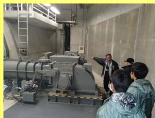
水力発電設備
