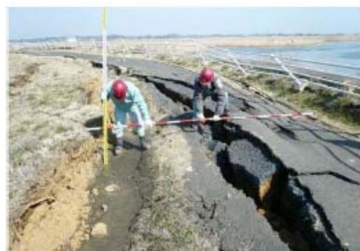
液状化による河川堤防への被害
