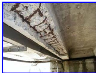
◇ 塩害により主析に発生した剥離・鉄筋露出
