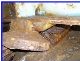
◇ 鋼製支承の損傷
