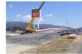
▲北陸地整による応急組立橋設置状況
