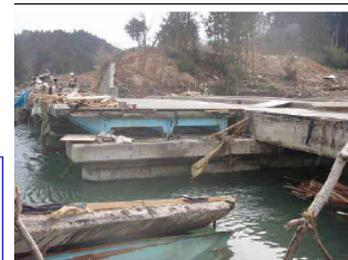
▲水尻橋(上部工及び橋台背面盛土流出)
