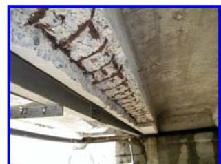
◇塩害により主析に発生した剥離・鉄筋露出
