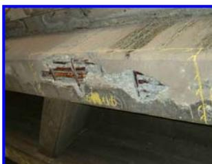
◇経年劣化及び中性化による主析コンクリートの剥離及び鉄筋露出
