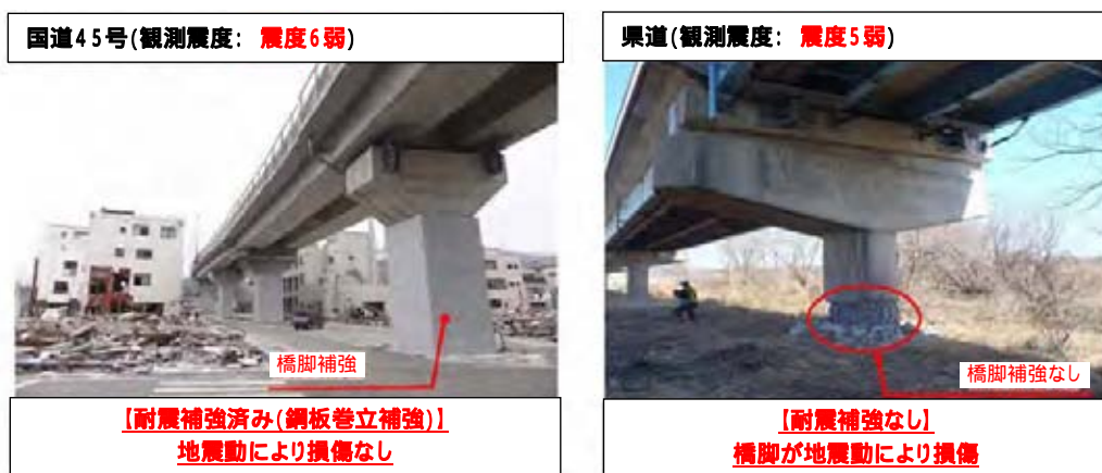
橋脚耐震補強の事例 2)
