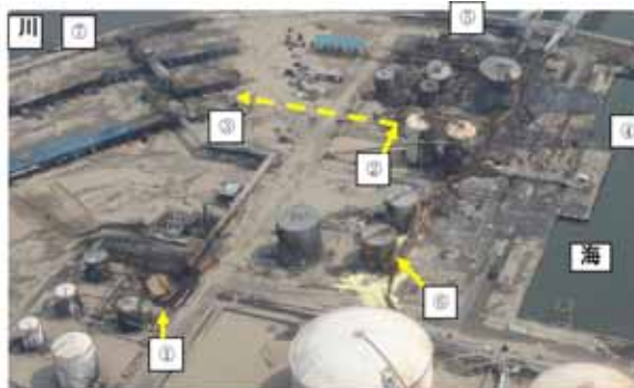
写真 12 火災が発生した区域
