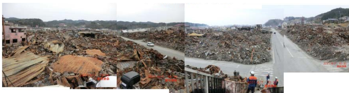
津波漂流物からの火災発生後の状況(宮城県気仙沼市) 4)
