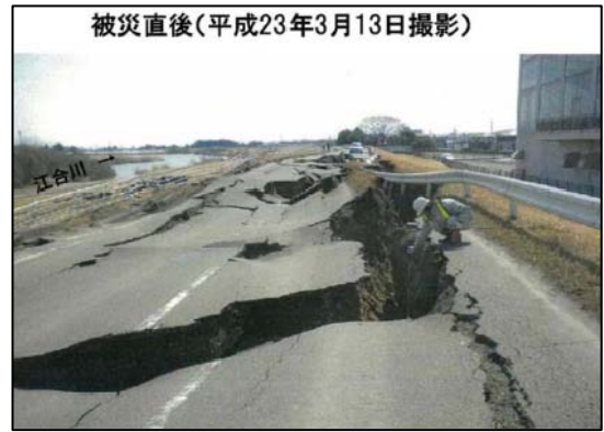
北上川水系江合川の河川堤防被害事例
