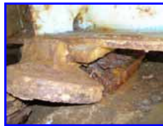
鋼製支承の損傷 ・R29須澄橋 (建設後48年経過H21補修予定)
