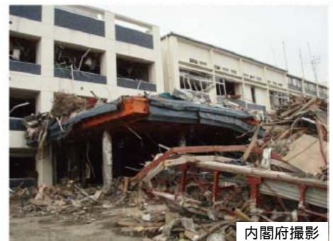
陸前高田市役所の被災状況 7)
