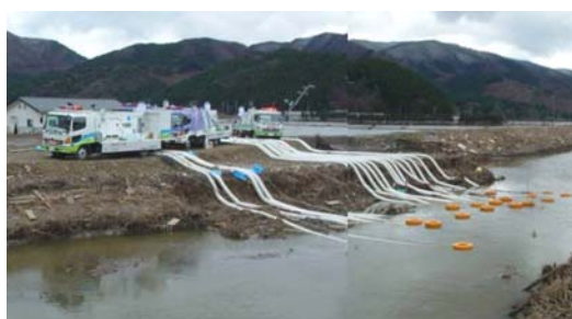
写真 2 5 浸水地域の排水作業 （石巻市釜谷）
