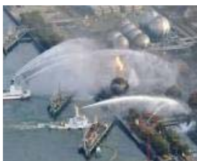
写真17 コンビナート火災の状況
