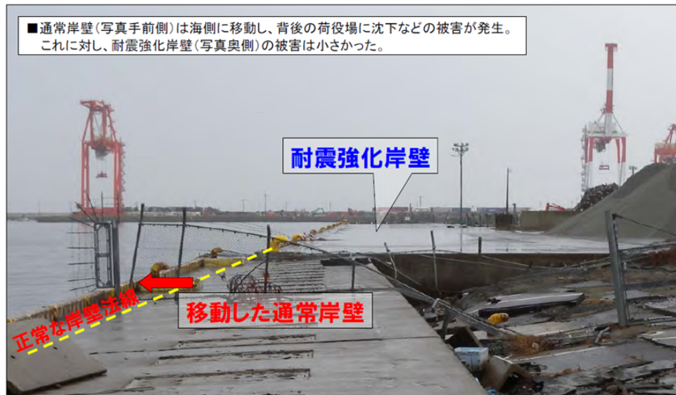
写真28 耐震強化岸壁の事例（仙台塩釜港 仙台港区）
