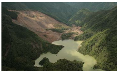
写真15 台風12号による土砂災害の発生事例
