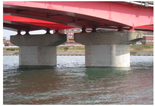
写真11 橋脚巻立ての例
