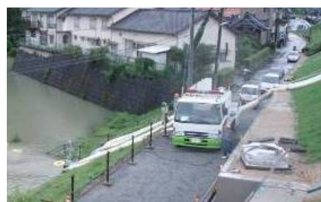
写真 2 6 浸水箇所の排水作業
