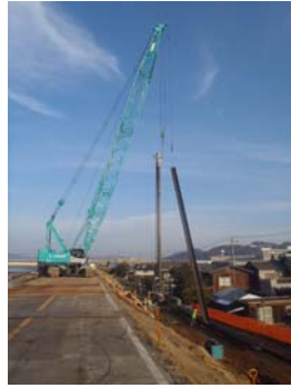
写真27 堤内側での耐震対策実施状況（高梁川左岸 距離標0k付近）
