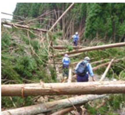
写真7 被災現況調査
