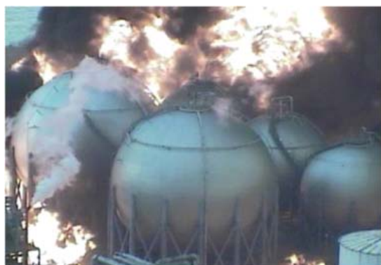
写真1：東日本大震災での東京湾臨海部におけるLPGタンクの被災状況（千葉県市原市）
