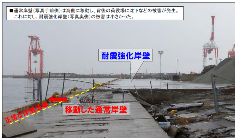
写真 2 9 耐震強化岸壁の事例（仙台塩釜港 仙台区）
