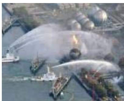
写真18 コンビナート火災の状況
