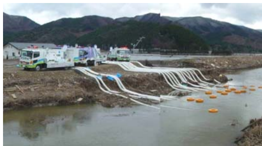
写真 2 6 浸水地域の排水作業 （石巻市釜谷）
