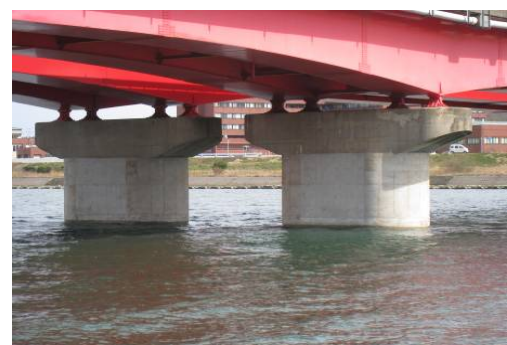
写真12 橋脚巻立ての例
