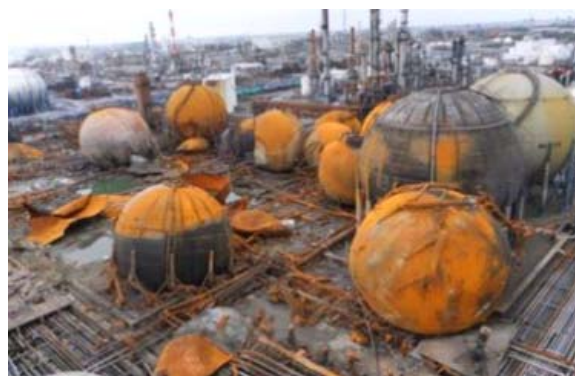
写真1：東日本大震災での東京湾臨海部におけるLPGタンクの被災状況（千葉県市原市）
