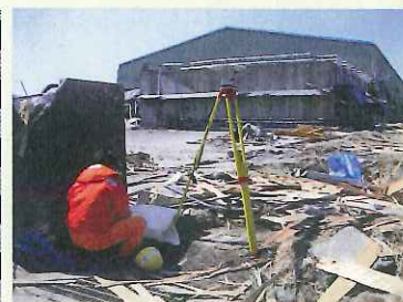
測量作業の様子
