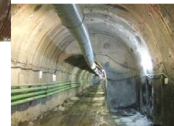
地すべりの動きを止めるための深礎杭施工、排水トンネルの設置
