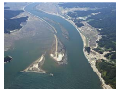
東日本大震災での浸水被害
