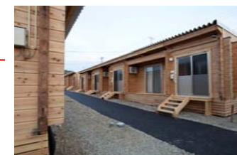
被災者向け住宅 （東日本大震災）
