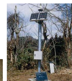
GPSを活用した地すべり監視
