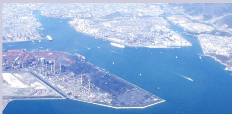
水島港内の状況
